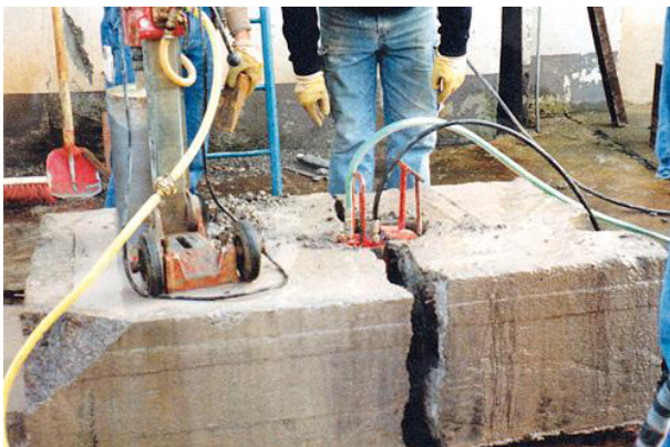
Abb. 8 Spalten mit Presszylindern
