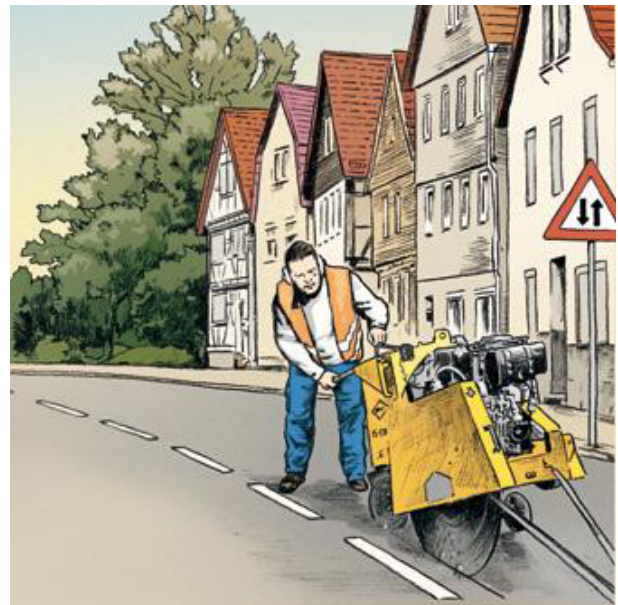
Abb. 3 Fugenschneiden
