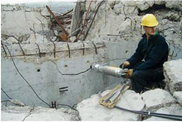
Abb. 7 Spalten durch Pressen – Keilprinzip
